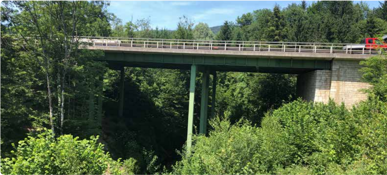
Seit Jahrzehnten trägt die Ölgraben-Brücke tagtäglich tausende Fahrzeuge; bis 2025 soll die Brücke erneuert werden. Foto: asfinag/DI Spalt
