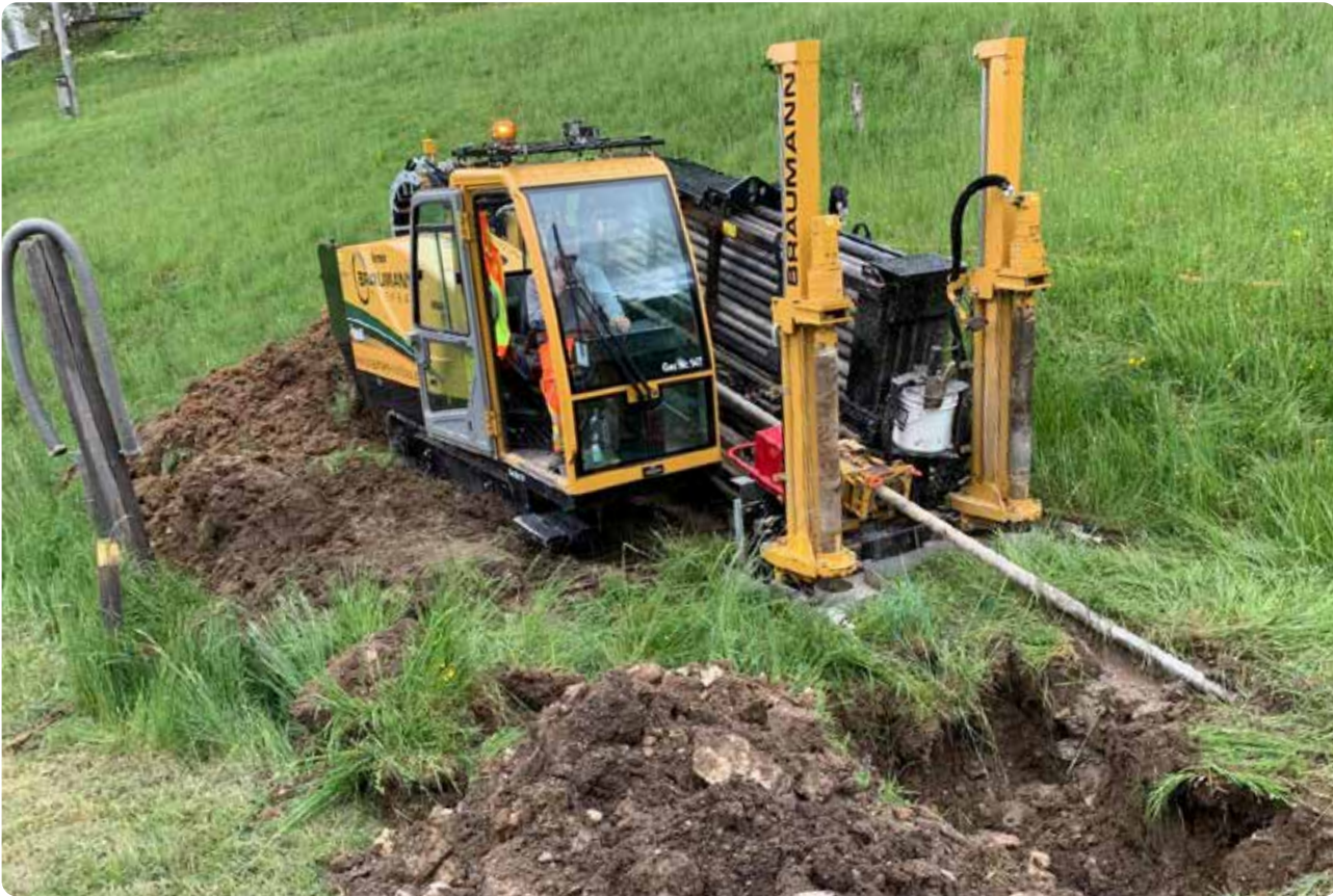
Mehrere Monate wurde für den Ausbau der Wasserversorgung Niedersee gegraben und gebohrt. Foto: Gemeinde
