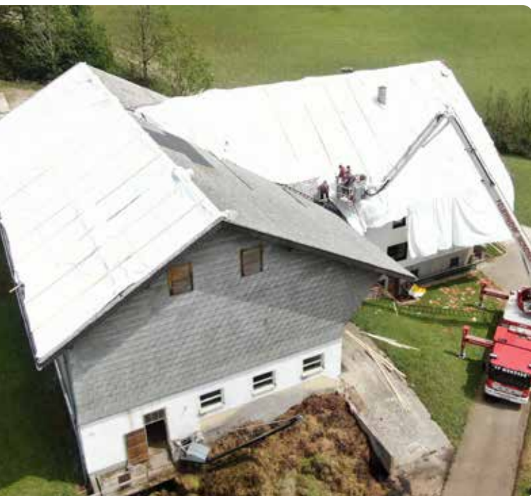
Mehr als 100 Dächer mussten nach dem Unwetter abgedichtet werden; die Planen wurden aus dem für solche Fälle vorgesehenen Lager aus Lenzing herantransportiert und über Kranfahrzeuge bereit gestellt. Foto: FF Tiefgraben (Stoxreiter) / BFK (Thalhammer)
