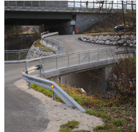
Die Aufschließungsstraße Steinerhof brachte eine bessere Anbindung an die Herzog Odilo Straße.
