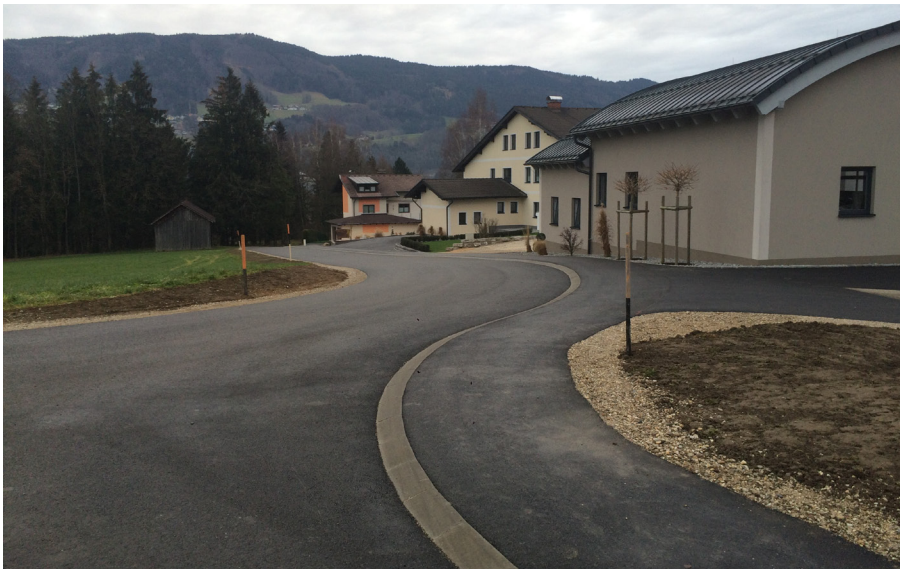
Entlang der sanierten Gaisbergstraße wurde auch ein 1,5 m breiter Gehsteig angelegt.
