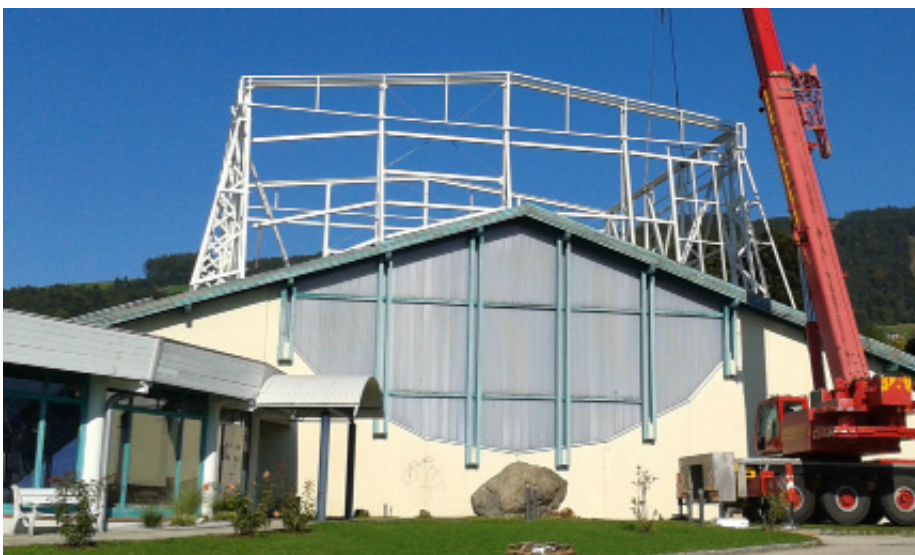
Das Gerüst für den Kletterturm im Vitaclub Mondsee wächst in die Höhe. Noch heuer ist Eröffnung der Kletterhalle. Foto: REGMO
